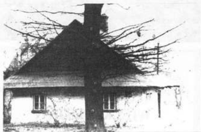
To już historia. Budynek rozebrano w ub. miesiącu.
