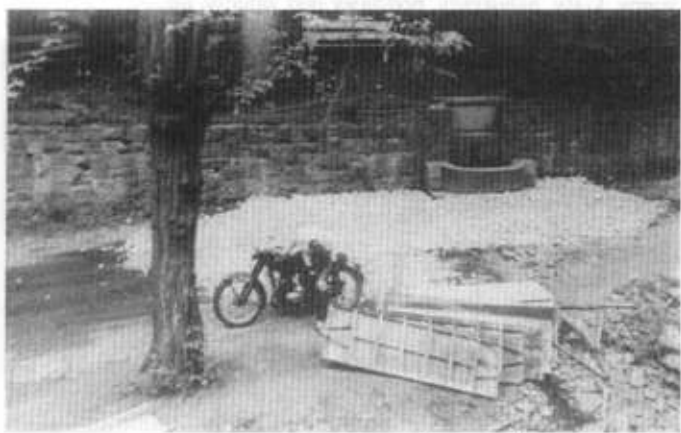
Trwają prace przy potoku Gościradowiec. Źródło żelaziste na razie nie zachęca swym wyglądem. Fot. W. Suchta
