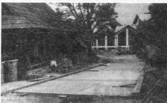
Trwa remont ul. Ogrodowej
