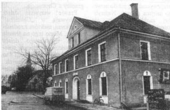
Udało się wyremontować skrzydło południowe.
