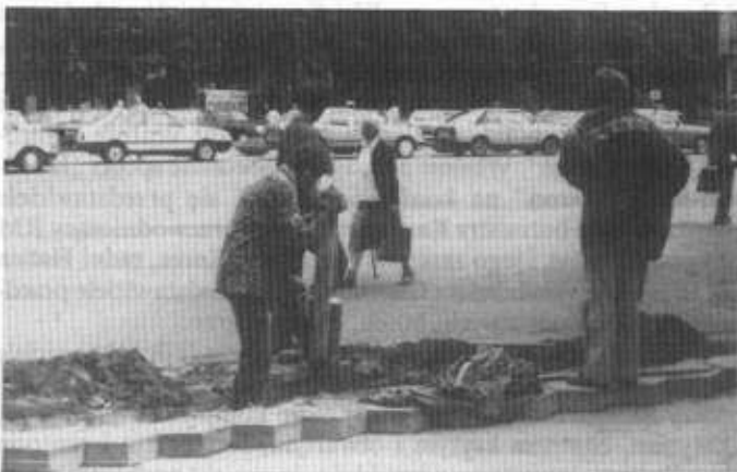
Roboty przy wymianie kabla energetycznego w Rynku
