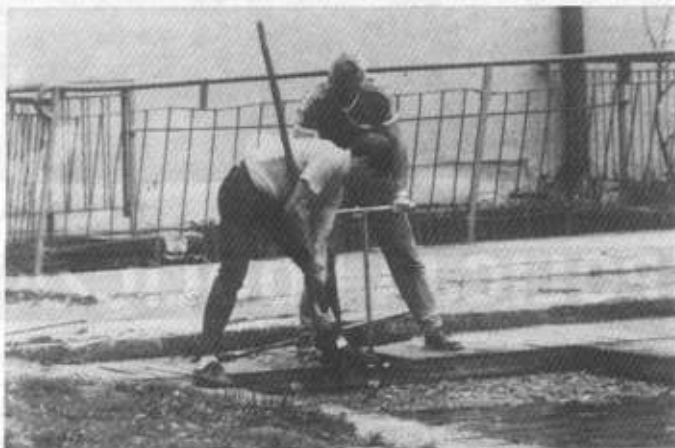
Po zakończeniu sezonu, na stawie kajakowym zabrano się za remont. Fot. W. Suchta
