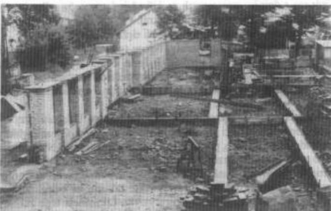
Trwają prace przy budowie nowego skrzydła SP-1. Koniec I etapu robót wyznaczono na 15 października. Fot. W. Suchta
