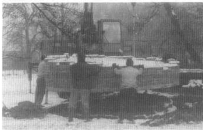
Stawianie cokołu pod niewytop.
