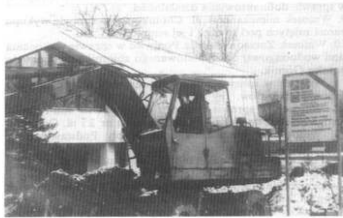
Przekop przez ul. Grażyńskiego miał na celu połączenie kanalizacji Banku z ul. Ogrodową. Fot. W. Suchta
