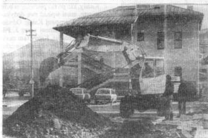
Powstaje parking przed Bankiem Spółdzielczym. Wykonuje go firma „Sigmat” z Hermanic. Fot. W. Suchta
