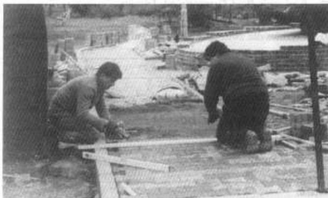
Prace w otoczeniu niewytopu
