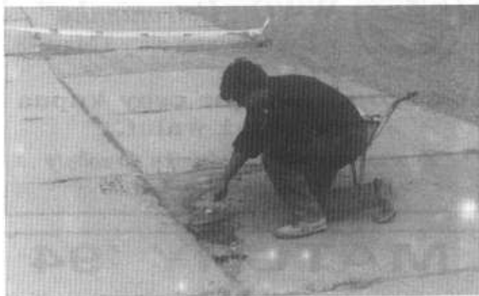
Trwa remont drogi przy targowisku.
