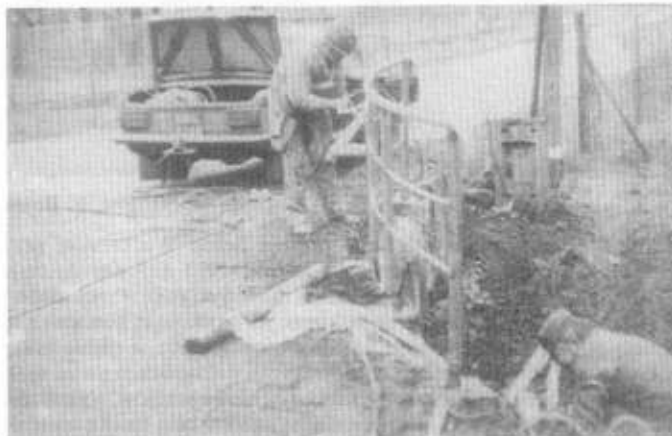
Szybko uporano się z rozbitą poręczą mostka na ul. Słonecznej.
