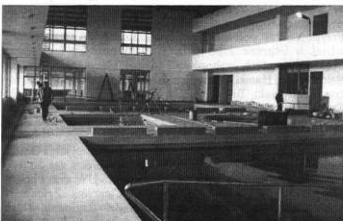
Ostatnie porządki przed oddaniem basenów.
