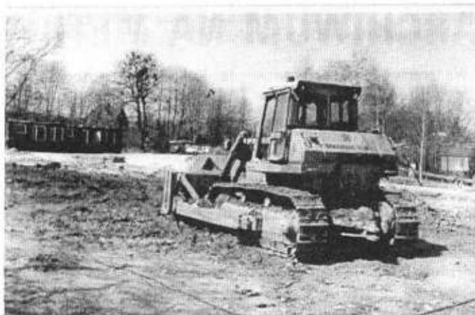
Ruszyła budowa obwodnicy.
