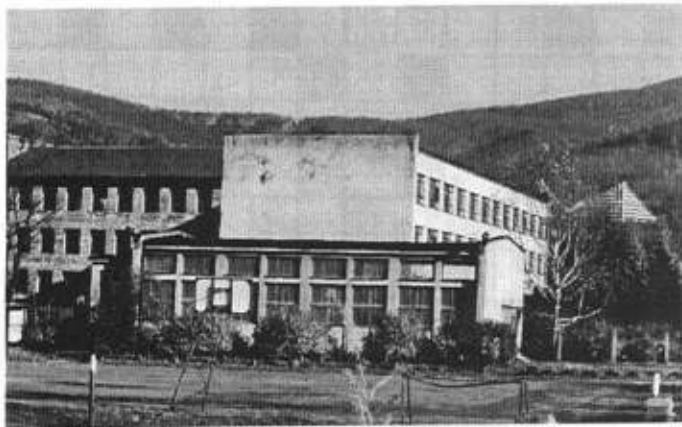
Trwa rozbudowa SP 1
