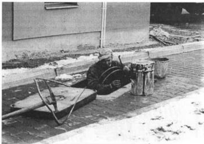
Trwa telefonizacja budynków przy ul. Gałczyńskiego.
