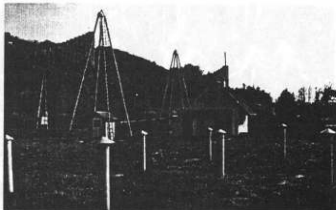
Odwierci eksploatacyjne. Na pierwszym planie wywietrzniki ze zbiornika surowej solanki.
