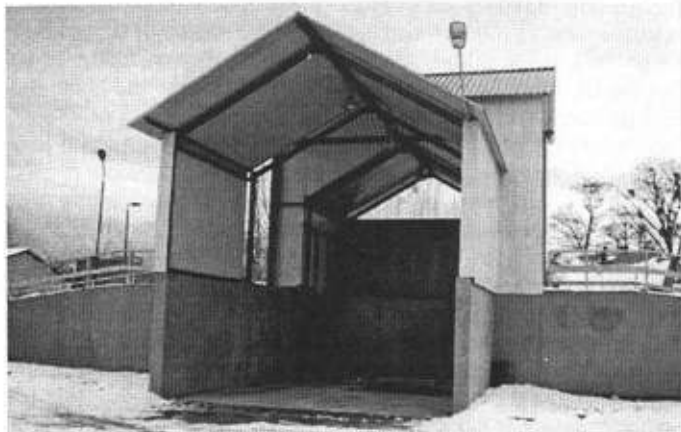
W stacji przeładunkowej, która powstaje na terenie byłej betoniarńi, mają być zachowane wszystkie rygory ochrony sanitarnej.
