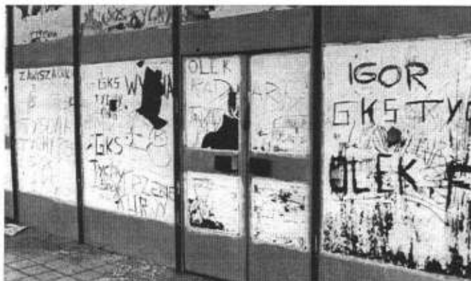
Tak dziś wygląda niegdyś reprezentacyjne wejście do kawiarni w centrum Jaszowca. Fot. W. Suchta
