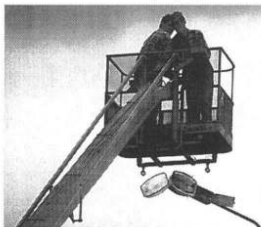
Pracownicy Zakładu Energetycznego na bieżąco wymieniają przepalone żarówki w lampach ulicznych. Pomocny jest tu specjalistyczny samochód z wysięgnikiem. Fot. W. Suchta
