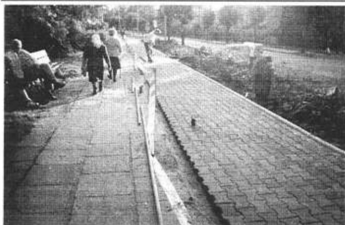
Kolejną część ul. Grażyńskiego, od skrzyżowania z ul. Słoneczną do przejazdu kolejowego, pokrył nowy chodnik. Fot. M. Niemiec
