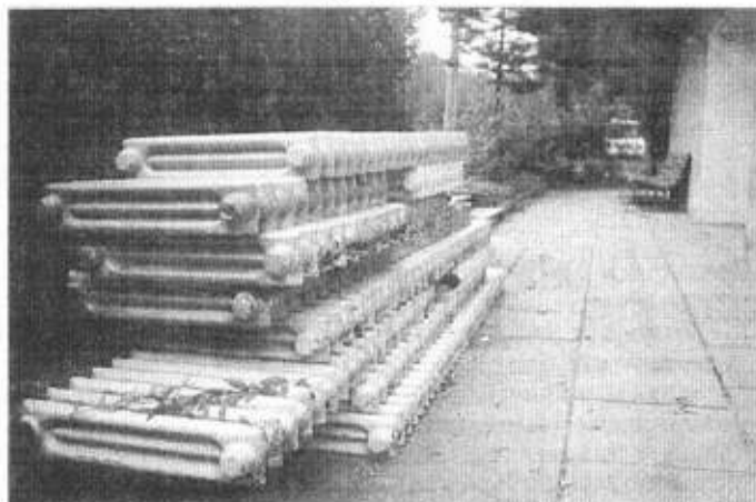
Trwa wymiana grzejników na os. M. Konopnickiej. Fot. M. Niemiec
