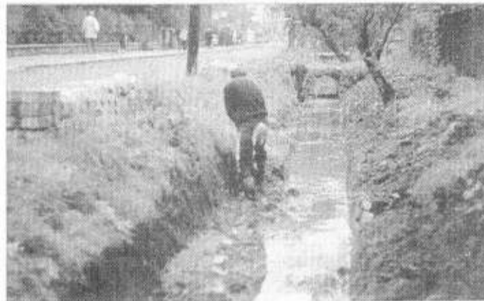
Ostatnio, na zlecenie Wydziału Ochrony Środowiska UM, firma Andrzeja Śmieszka z Drogomyśla pogłębiała rów przy ul. Andrzeja Brody. Fot. W. Suchta
