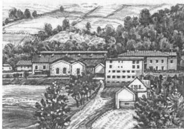
Widok na zabudowania huty i odlewni, a także na budynek spółdzielczy i Hotel Kuracyjny w latach trzydziestych. W tle Zawodzie.
