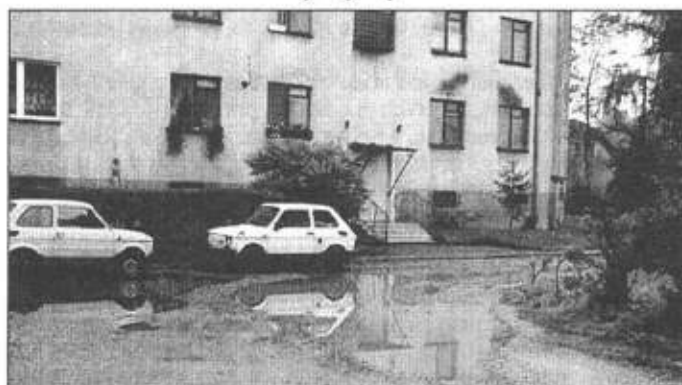
Mieszkańcy tych bloków w Nierodzimiu mają problemy z dziurami w drodze, które po deszczach zamieniają się w olbrzymie kałuże. W Urzędzie Miejskim dowiedzieliśmy się, że jest to droga osiedlowa i jej naprawa należy do obowiązków właściciela budynków. Fot. H. Cieślak
