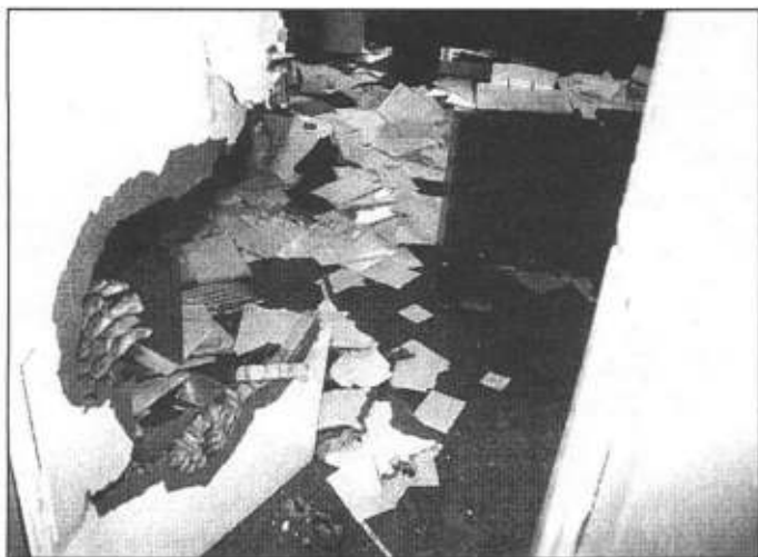
Zniszczenia w Przedszkolu Nr 2.
