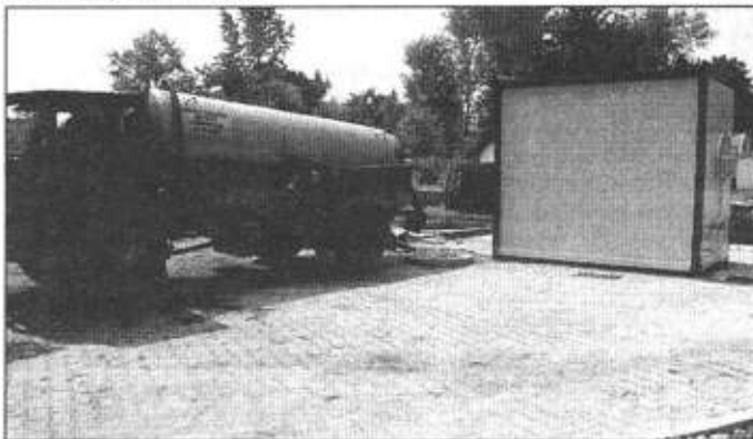
Nowa stacja zlewna.
