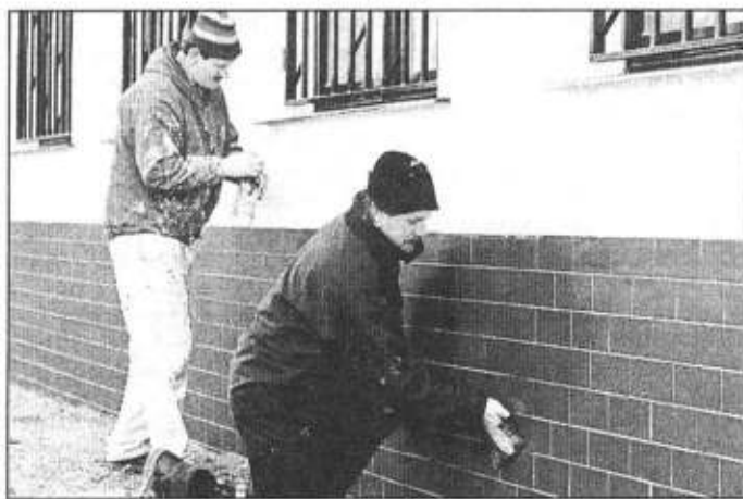
5 grudnia dokonano odbioru elewacji Gimnazjum nr 1. Przed odbiorem pucowano ściany. Fot. W. Suchta
