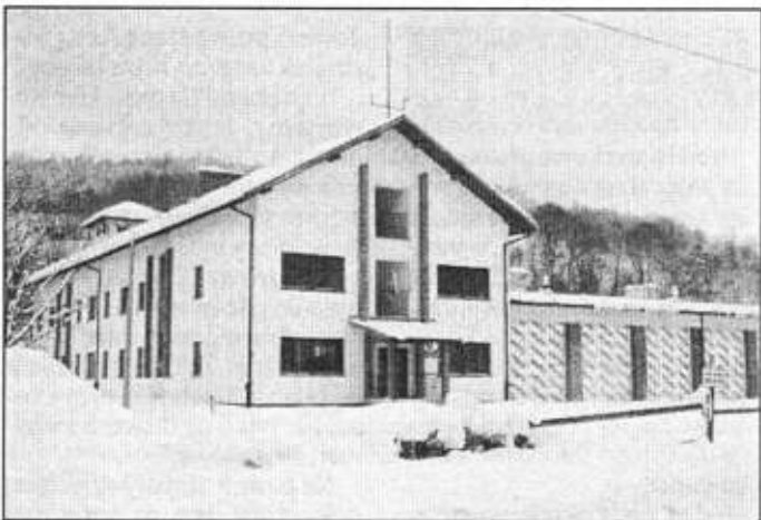
Trwa budowa nowej siedziby Państwowej Straży Pożarnej - Jednostki Ratowniczo-Gaśniczej w Polanie. Oddanie nowoczesnego obiektu planowane jest w tym roku. JRG w Polanie dba o bezpieczeństwo mieszkańców Istebnej, Wisły i Ustronia. Fot. W. Suchta
