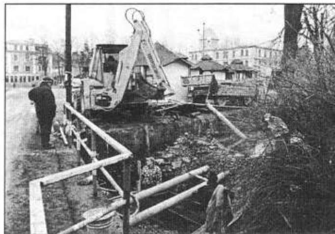
Powstaje pierwszy próg wodny na Bładnicze przy mostku na ul. A. Brody. Fot. W. Suchta
