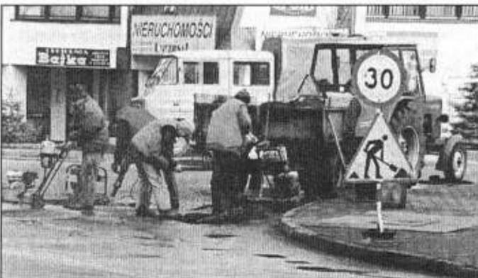
Kierowco, uważaj na roboty drogowe.
