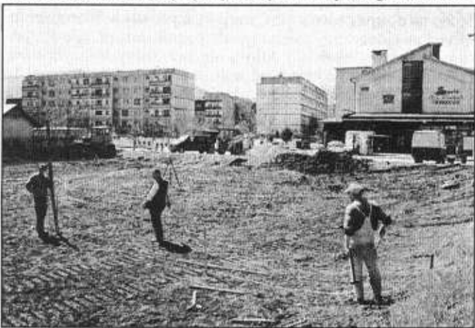
Powstaje nowy parking przy ul. Cieszyńskiej.
