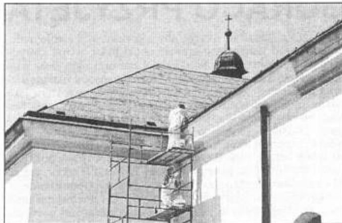
Malowanie kościoła św. Klemensa.
