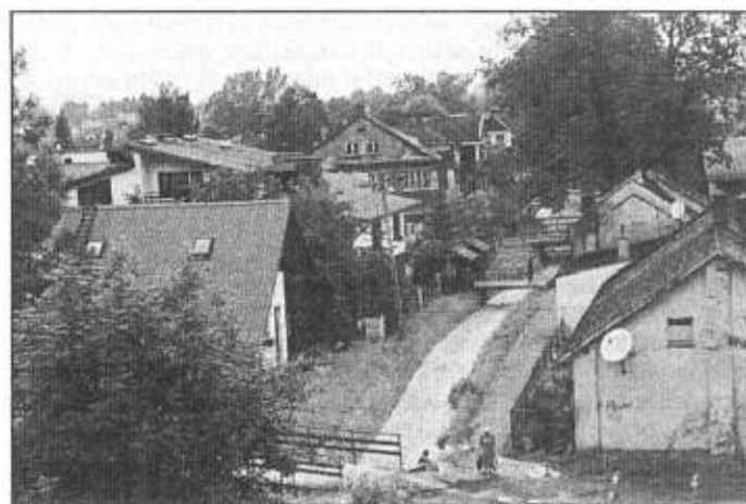
Przez betonową Bładniczkę woda płynie gładko, bardziej zagrożone są budynki nad Młynówką. Fot. W. Suchta
