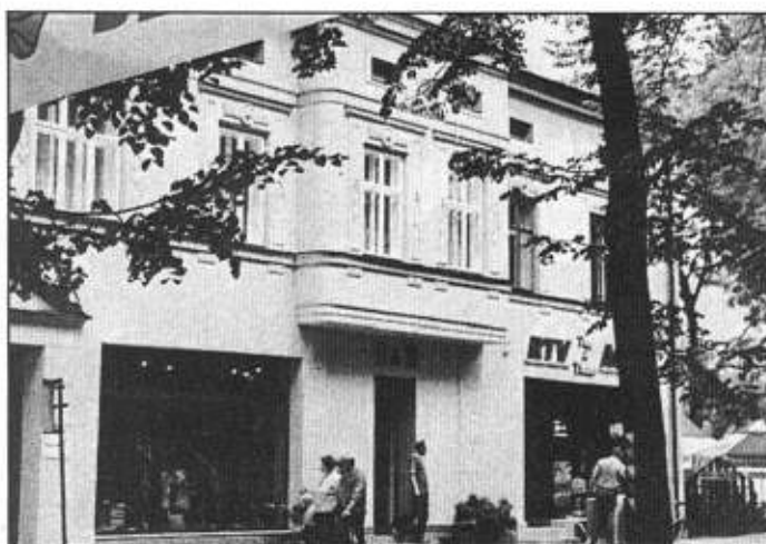
Nowe kreacje budynków, przy ul. 3 Maja... Fot. M. Niemiec
