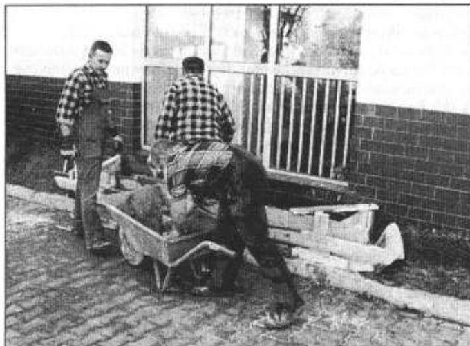
Murowanie cokołu pomnika pod Gimnazjum nr 1
