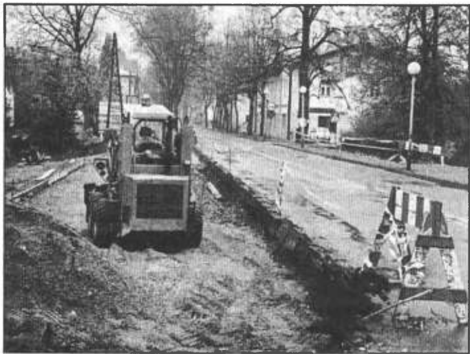
Budowę nowych zatok rozpoczęto jesienią. Kończono wiosną. Teraz czekamy na autobusy. Fot. W. Suchta
