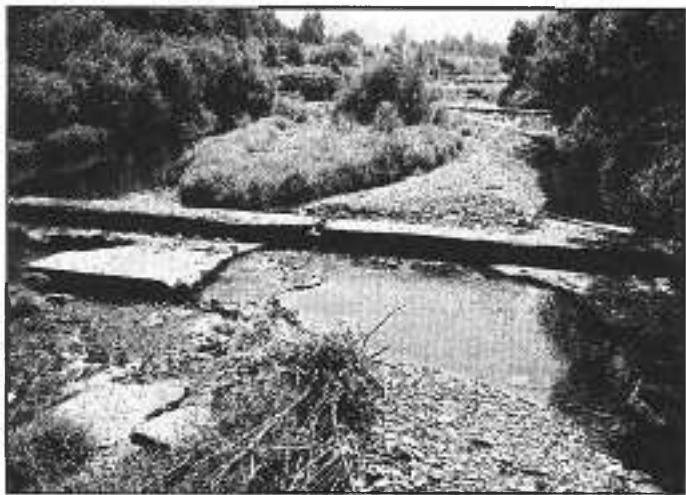
Próg na Wiśle w Polanie. Strach pomyśleć, że w tym miejscu mogą kąpać się dzieci. Fot. W. Suchta
