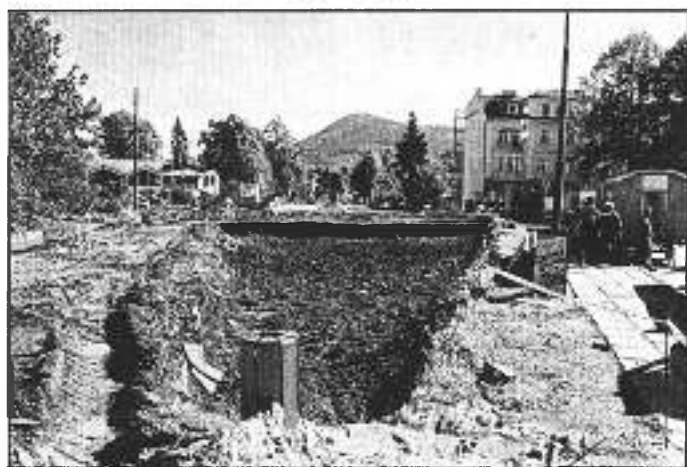
Trwa budowa ronda w centrum miasta. Na dawnym skwerku powstał okazały wykop. Przekładane są instalacje. Zmalał ruch samochodowy na rynku. Fot. W. Suchta
