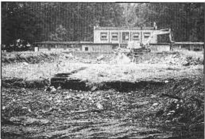
Przystąpiono do robót na terenie basenu kąpielowego. Rozpoczęto od rozbiórki niecki basenu i znajdującego się nieopodal brodzika. Fot. W. Suchta
