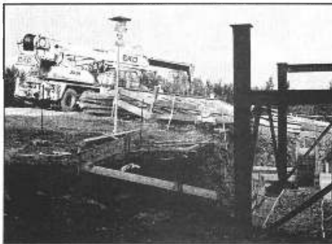
Na szczycie Czantorii rozpoczęły się roboty budowlane związane z budową wieży widokowej po czeskiej stronie. Są już fundamenty i pierwsze stalowe konstrukcje. Fot. W. Suchta
