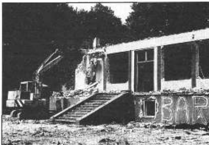
Przystąpiono do rozbiórki budynków basenu. Ciężki sprzęt rozbija ściany kawiarni. Fot. W. Suchta
