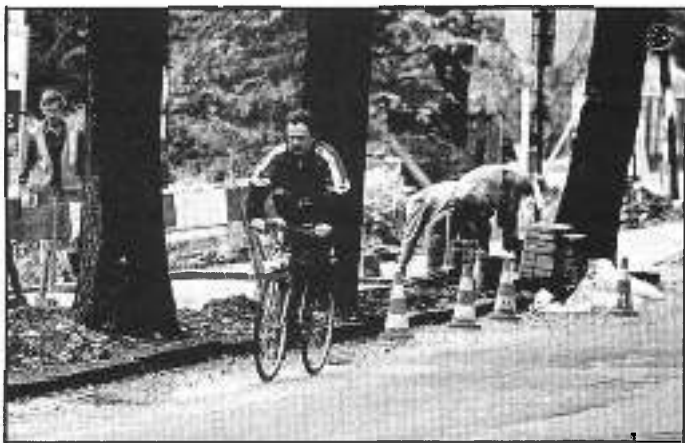
Powstaje nowy chodnik przy ul. 3 Maja.
