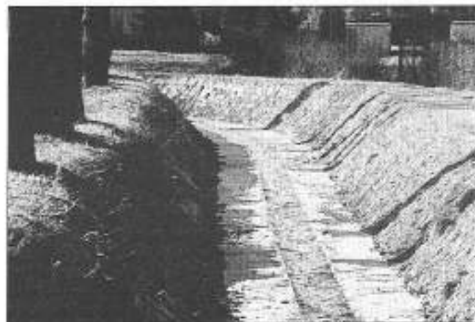
Wybetonowana Bładnica.
