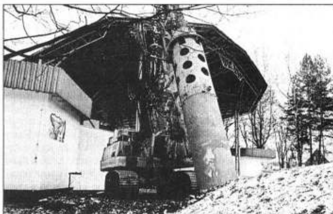
Rozpoczęto kopanie fundamentów pod konstrukcję zadaszennia amfiteatru. Fot. W. Suchta
