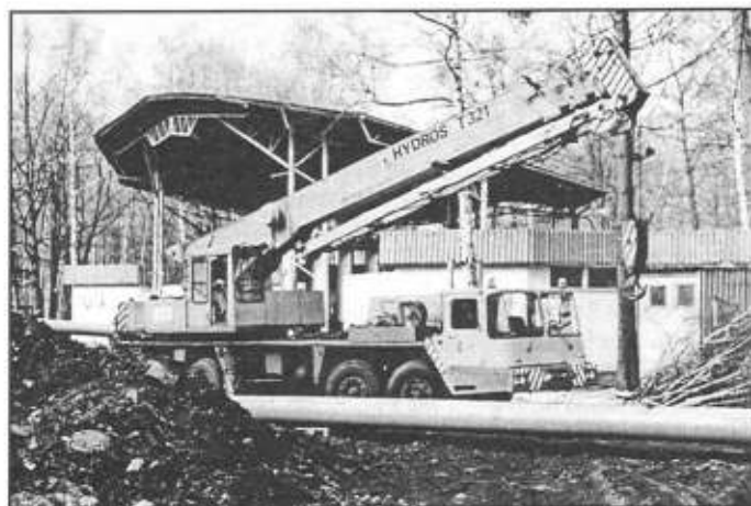
Do postawienia stalowej konstrukcji potrzebny będzie sprzęt ciężki. Na zdjęciu próba generalna dźwigu. Fot. M. Niemiec
