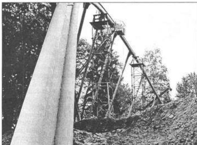
Tak wygląda większy łuk montowany z trzech części. Fot. W. Suchta
