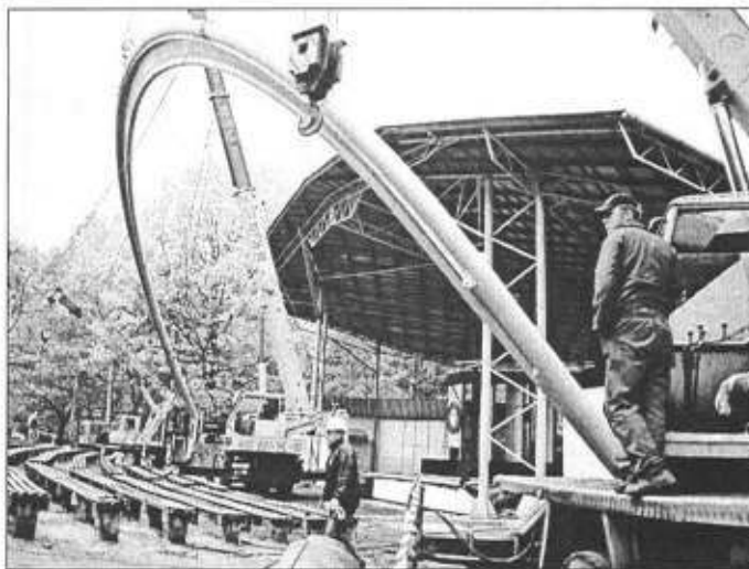
Mniejszy łuk nad sceną amfiteatru ustawiano przy pomocy trzech dźwigów. Fot. W. Suchta
