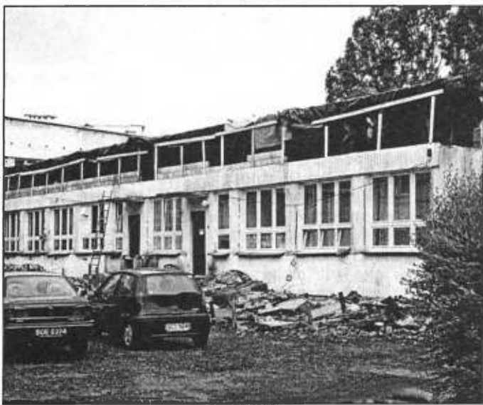
Rozpoczął się długo oczekiwany remont Szkoły Podstawowej nr 2. Roboty dotyczą głównie ocieplenia budynku i remontu dachów. Fot. W. Suchta
