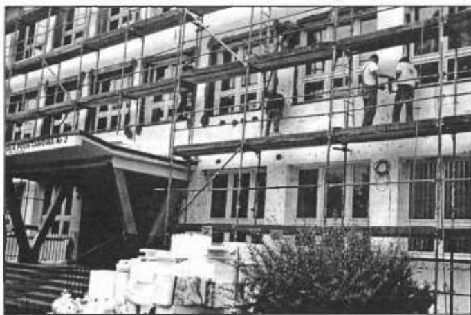
Trwa remont Szkoły Podstawowej nr 2.
