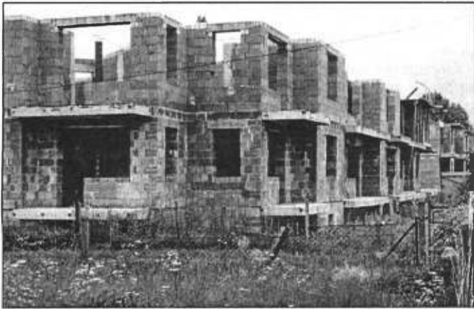
Na osiedlu TBS wyrosła druga kondygnacja.
