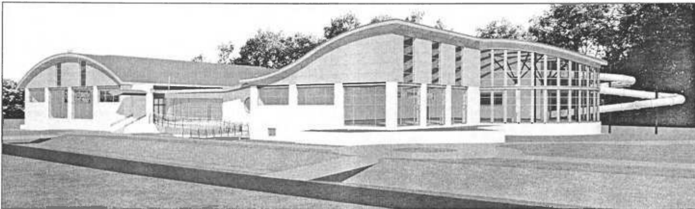
Widok na halę sportową i część basenową od strony bulwarów nad Wisłą. Z prawej strony - zewnętrzna zjeżdżalnia, licząca 52 metry długości.
