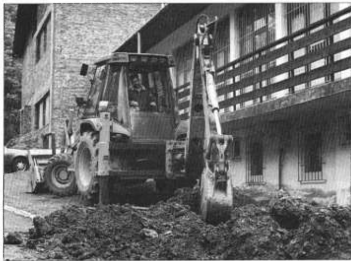
Trwają prace kanalizacyjne w Lipowcu.
