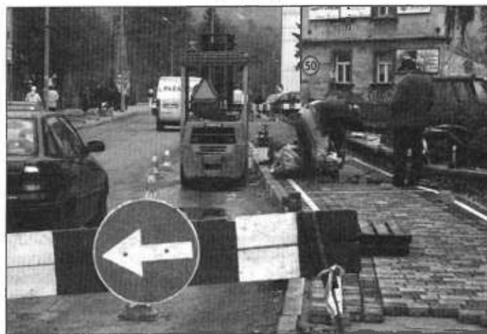
Trwa budowa chodników w centrum.
